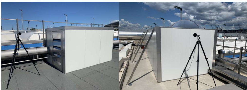
FIGURA 31 – INSTALLAZIONE DI SCATOLA FONOISOLANTE E FONOASSORBENTE E PANNELLI FONOISOLANTI
